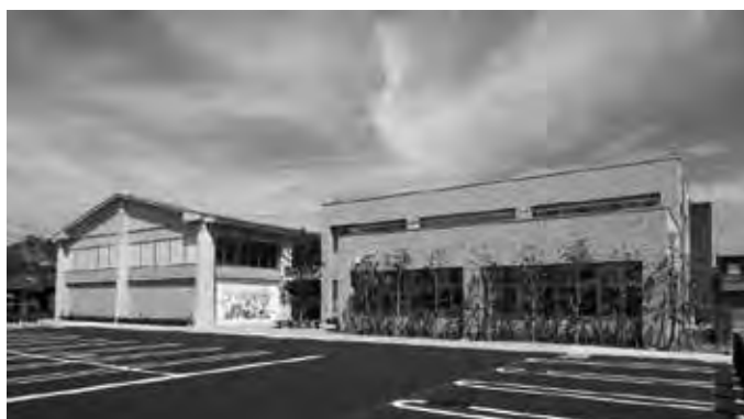
長岡コミュニティセンター(平成23年竣工)
