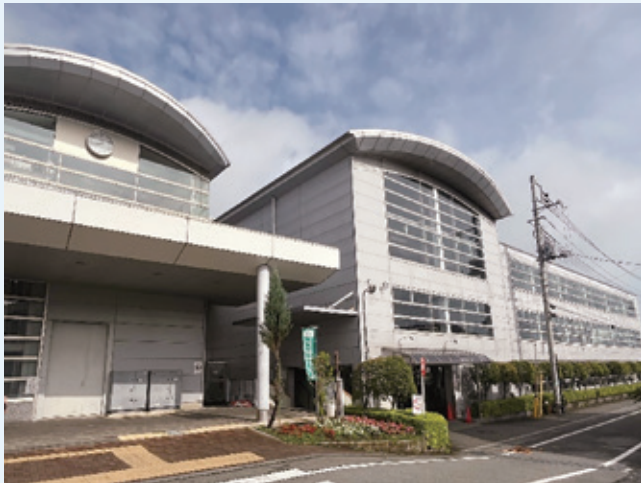
▲箱根ヶ崎駅自転車等駐車場(東口)
