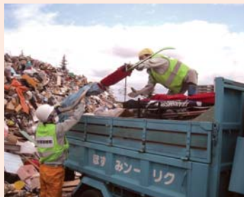
▲がれきの撤去作業（仙台市）
