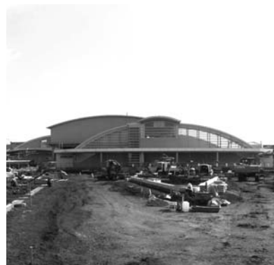
▲工事中の箱根ヶ崎駅西口
