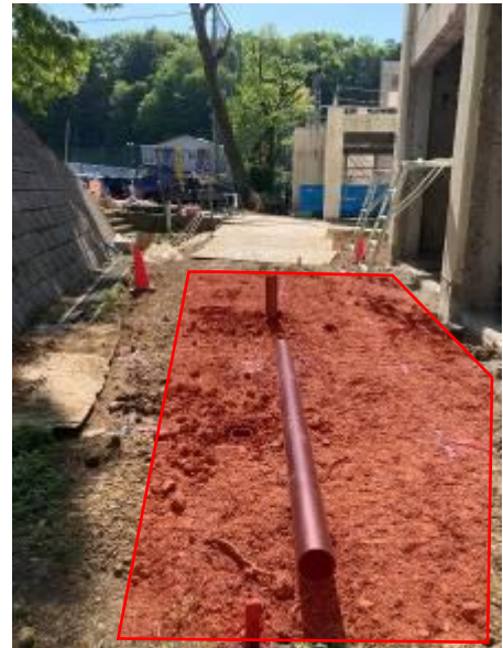
北棟増築部 (写真奥側が瑞穂中学校校庭)
