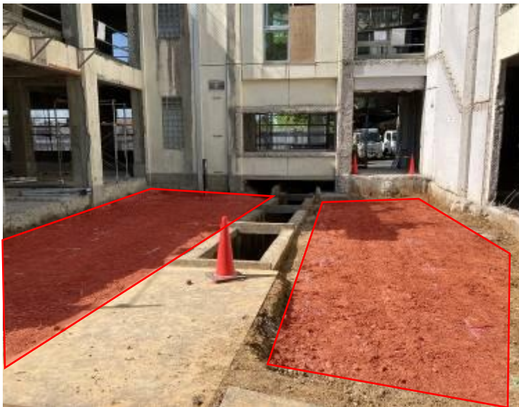
中央増築部 (写真左側が既存東棟、右側が既存西棟)
