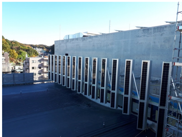
太陽光建材モジュール(建材一体型)
