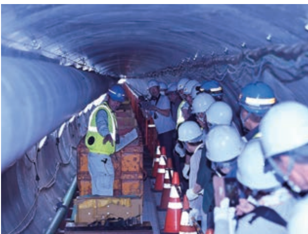
長岡1号幹線布設工事現場見学会
