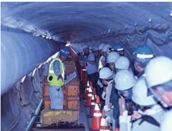
長岡1号幹線布設工事現場見学会
