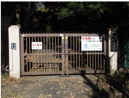
石畑給水所正面ゲート（内部は立入禁止）
