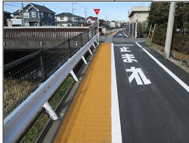
H28年度町道440号線 二本榎橋付近
