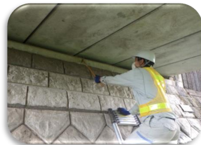
近接調査風景
