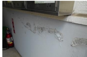
外壁の塗膜剥離
