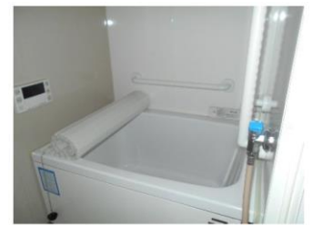
浴室のユニットバス化・手摺の設置
