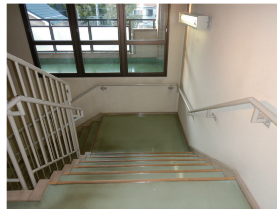
建物 2 階 階段室（長尺シート）
