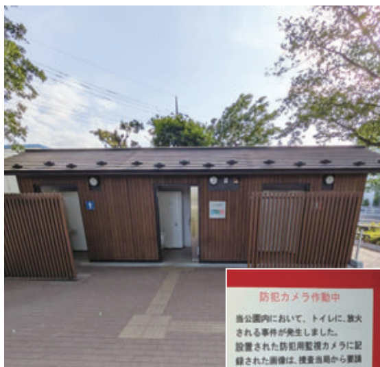
下師岡公園トイレと町が対応したトイレ内の注意喚起
