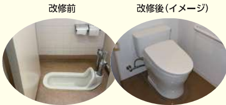
改修前の瑞穂中学校トイレ(左)と、改修後イメージ(右・瑞穂町多世代交流センター MIZCUL)
