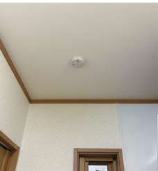
平成23年から設置が義務付けられた住宅用火災警報器(上)と初期消火に有効な消火器(右)
