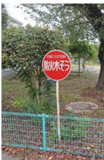
公園に設置された防火水槽（むさし野地区）
