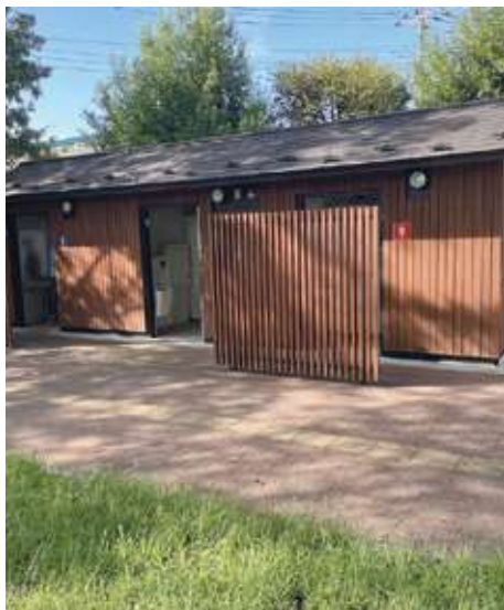
下師岡公園に設置されているトイレ
