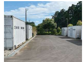
元狭山広域防災広場に設置されている防災倉庫
