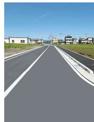
区画整理後の道路（殿ヶ谷地区）
