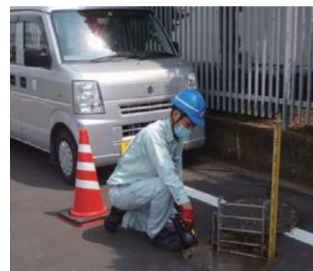
マンホール内を確認している職員
