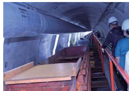
6年8月に開催された工事現場見学会
