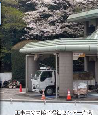
工事中の高齢者福祉センター寿楽
