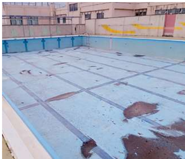
改修前の二中プール
