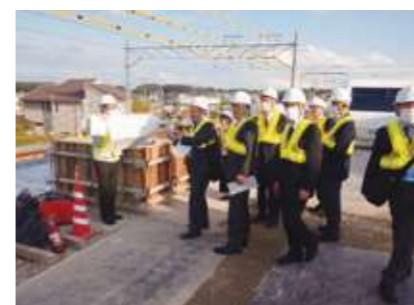
新駅建設中の現地を視察する様子
