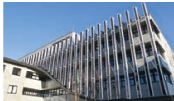
庁舎西側に設置されている太陽光発電のルーバー
