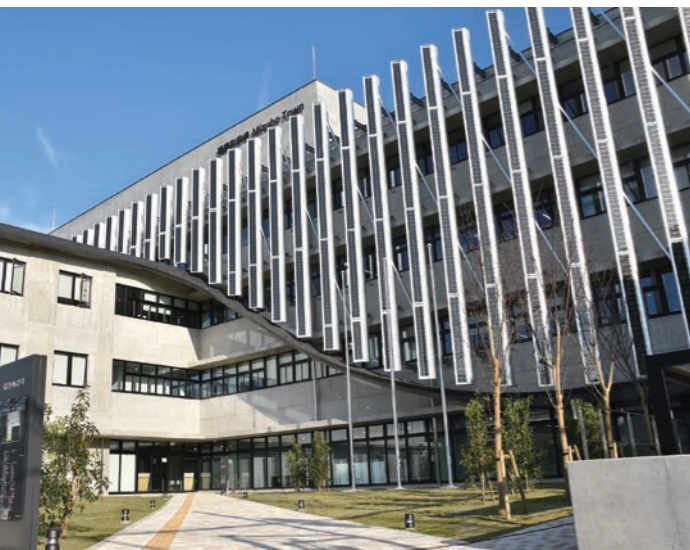
完成した新庁舎
