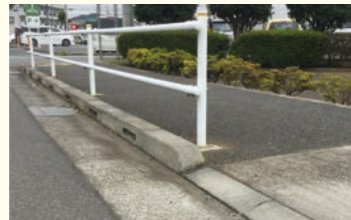
歩道がセミフラット形式で施工されている都市計画道路3・5・24号線（町営グランド駐車場付近）
