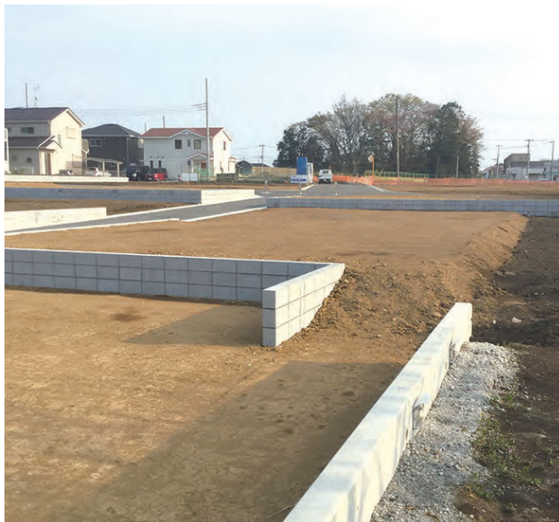
箱根ヶ崎駅西地区の土地区画整理事業地内
