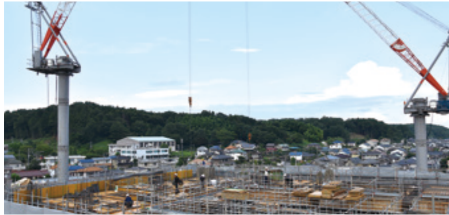
建設が進む新庁舎
