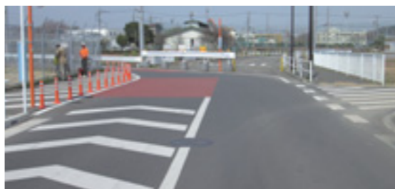
都市計画道路3・5・24号線（基地東側）
