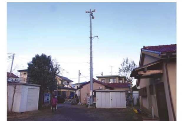
現在みずほさかえ公園に設置されている防災行政無線
