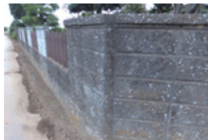
道路沿いのブロック塀
