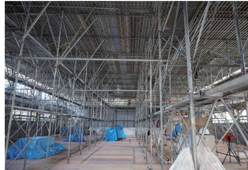
足場が組まれた体育館 (第一小学校)
