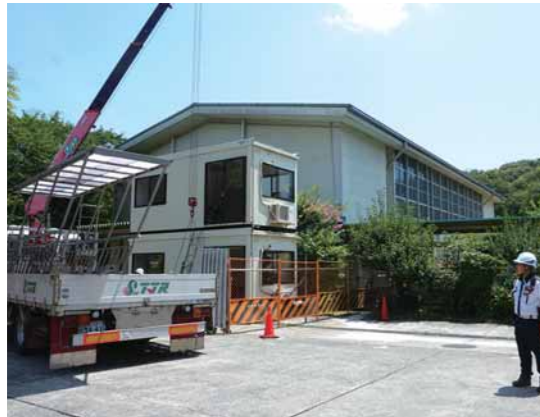
交通誘導員が配置されている様子 (第五小学校)
