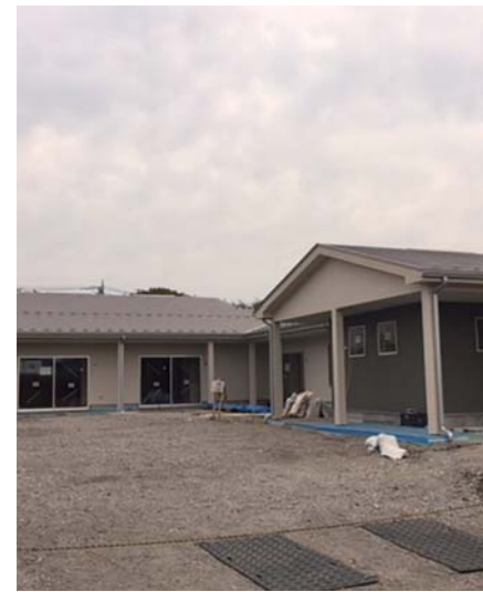
建設中の認定こども園 (南平地区)
