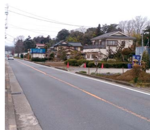
仮歩道新設を予定している都道179号線
