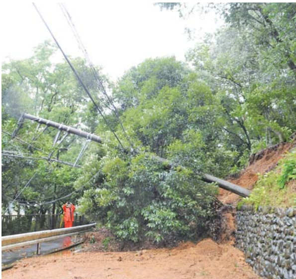
28年の台風9号による被害 (町道2号線)
