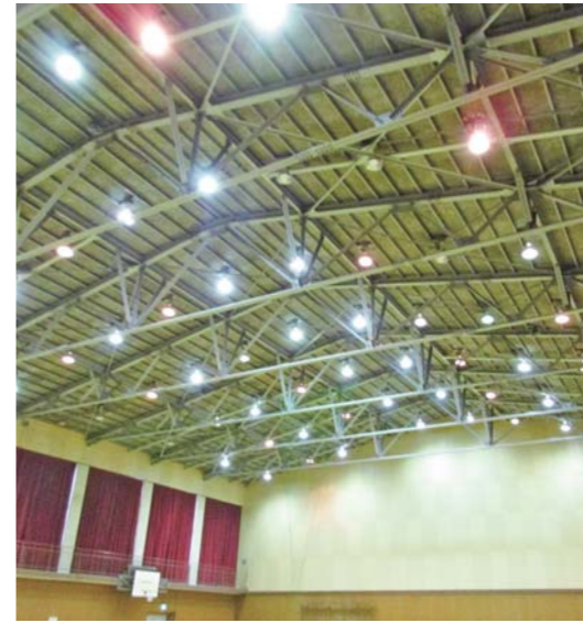
耐震工事を行った中央体育館の天井
