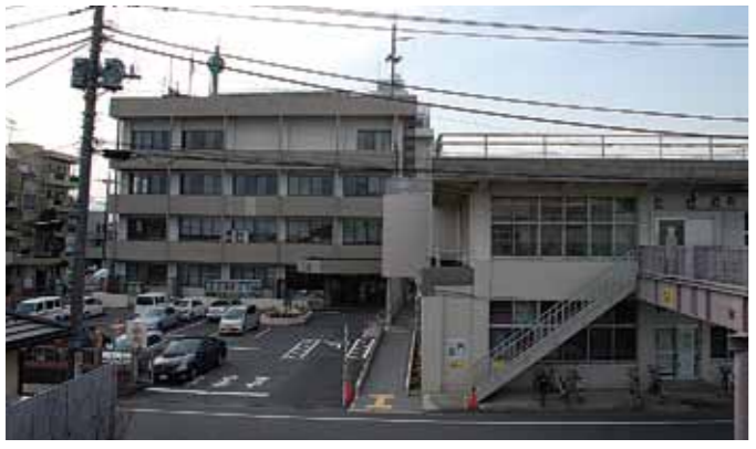
建て替えを予定している現庁舎
