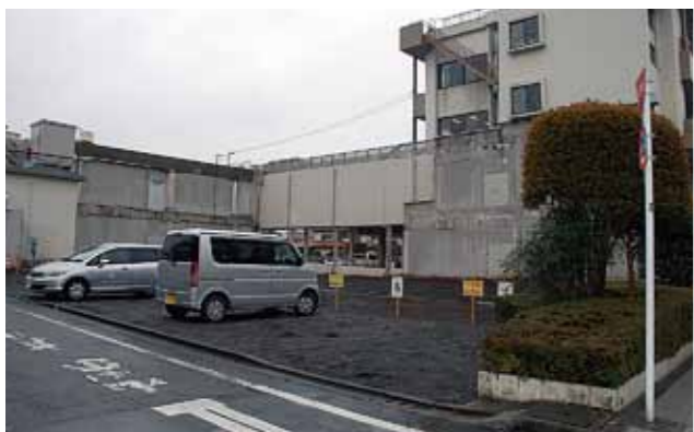
解体が終わった旧庁舎跡地
