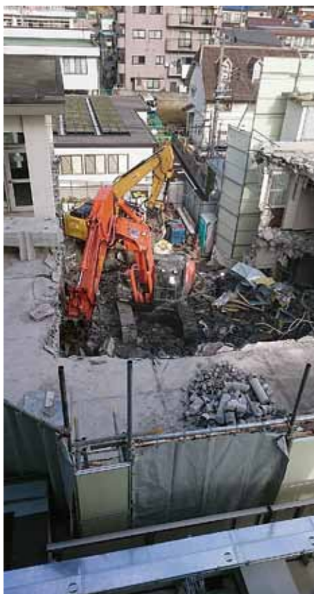
解体中の旧庁舎（27年1月）
