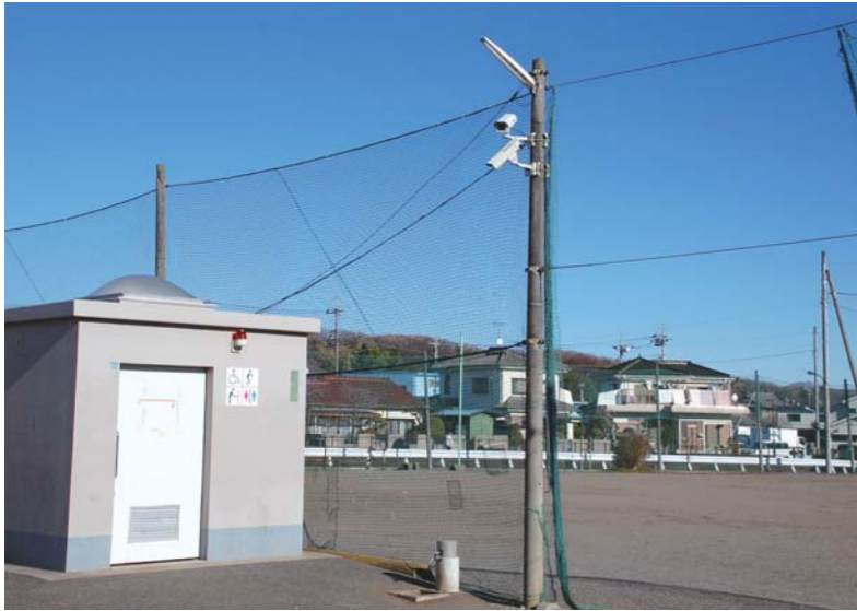
26年度設置された防犯カメラ（石畑地区）
