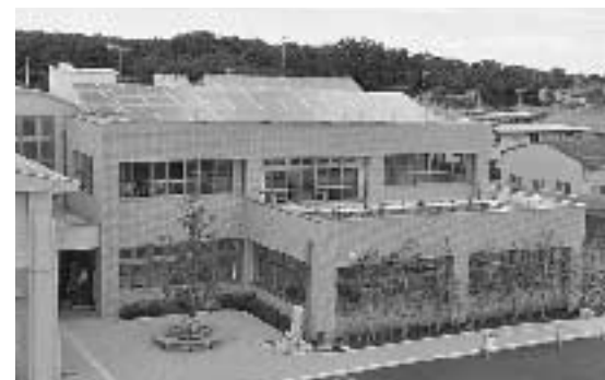
長岡コミュニティセンターに設置された太陽光パネル
