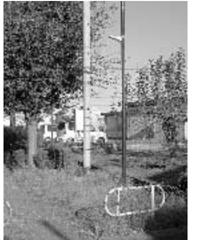
緑道に設置されているLED照明（長岡地区）
