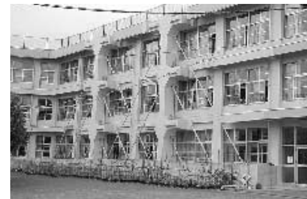
耐震工事が終了した第一小学校
