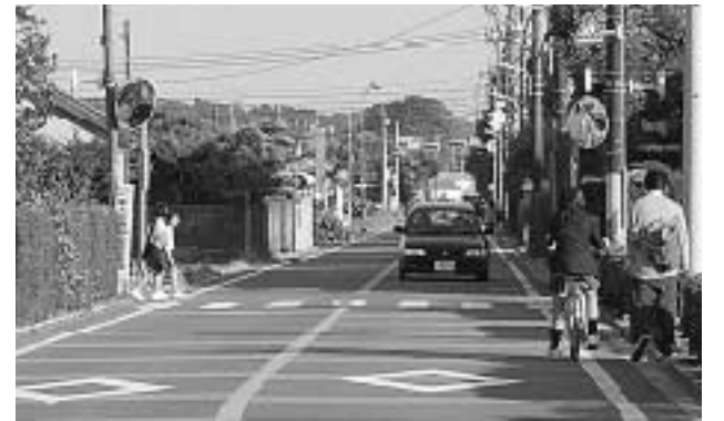
路面に安全対策を施した町道34号線(二中南側)
