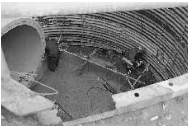
下水道工事(殿ヶ谷3号雨水幹線布設)
