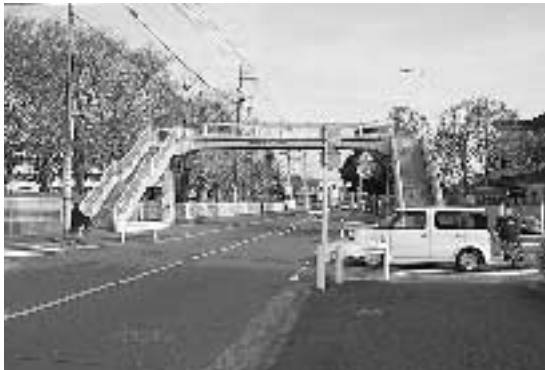
歩道橋が設置されている都営瑞穂アパート内の交差点
