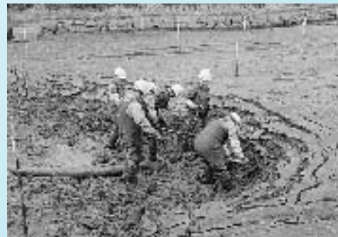
12月9日 産業建設常任委員会が視察した狭山池の浚渫工事 しんせつ
