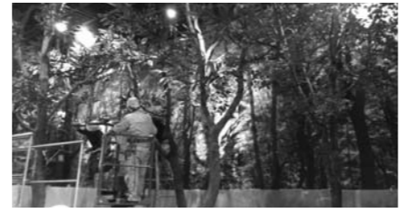
▲展示工事の様子
