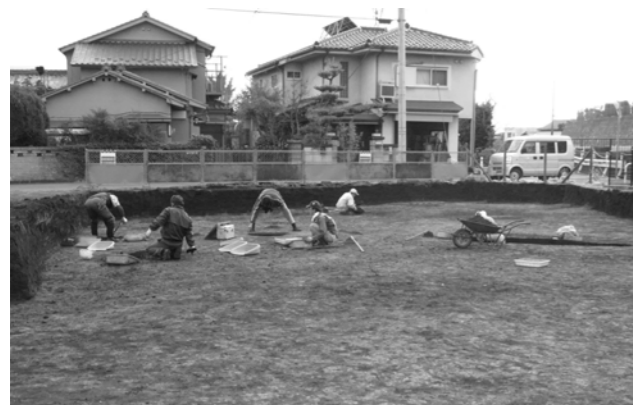
▲埋蔵文化財包蔵地における掘削工事の様子
