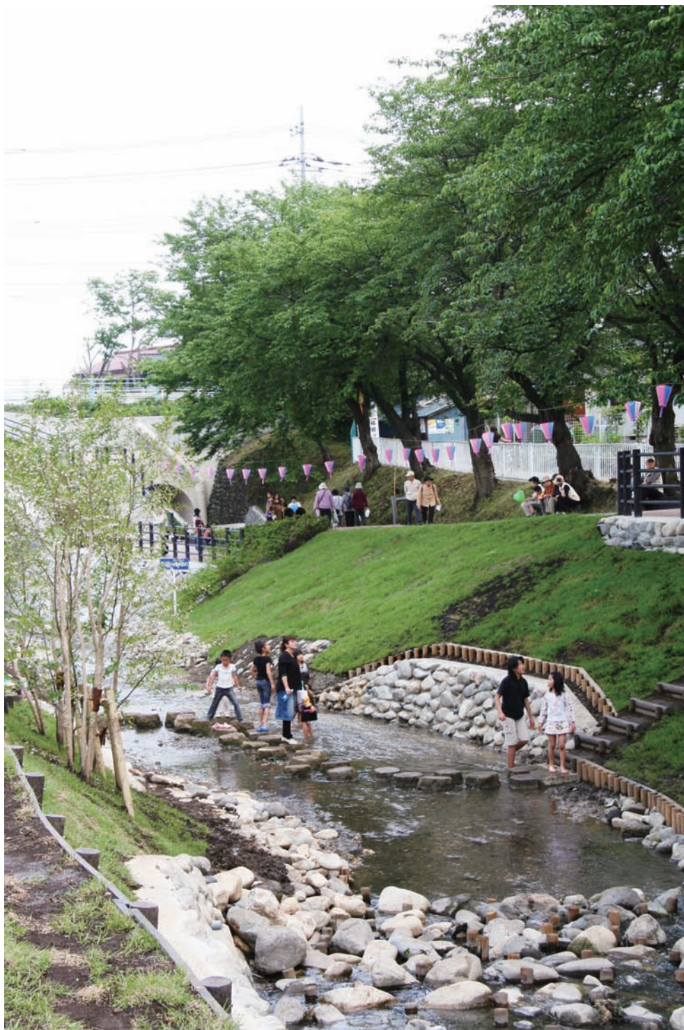
整備が完了した残堀川上流部
